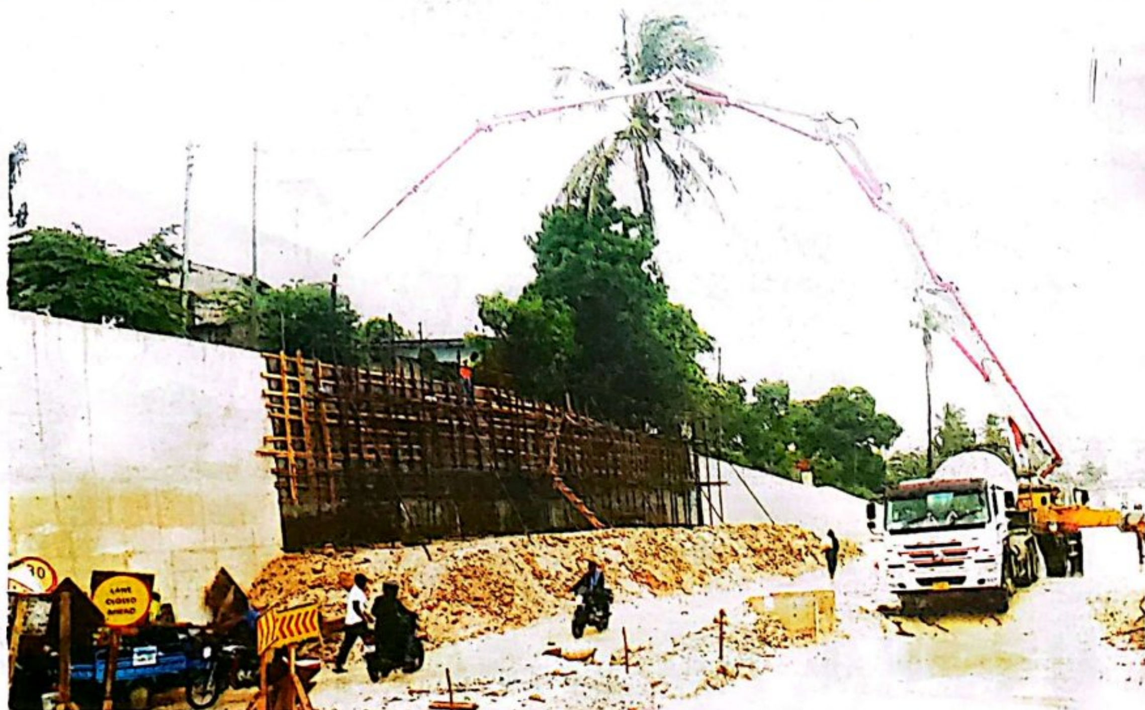
Mkandarasi akiendelea na ujenzi wa ukuta wa zege wa kuzuia mmomonyoko wa ardhi pembeni mwa barabara ya Morogoro, eneo la Kimara Kona, Manispaa ya Ubungu, Dar es Salaam jana, ikiwa ni sehemu ya upanuzi wa barabara hiyo inayotarajiwa kuwa na njia sita. PICHA: SABATO KASIKA
